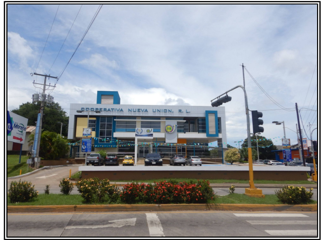
Vista del Sector.
