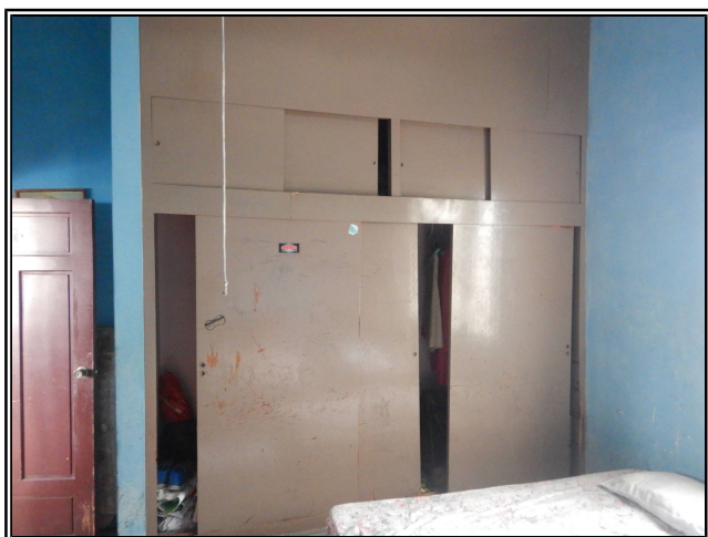
Vista del Closet de la Recámara N°2.
