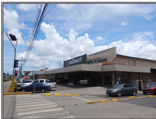
Vista del Sector.
